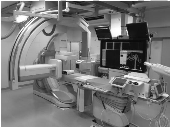
図1-2 大口径バイプレーン血管撮影装置が設置された検査室
