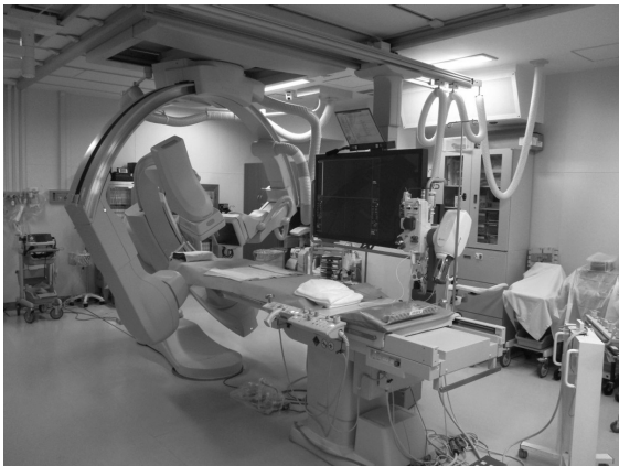
図1-1 高精度バイプレーン心血管撮影装置が設置された検査室
