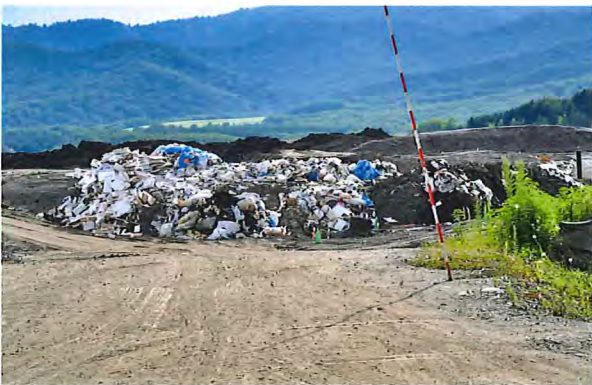
旭川廃棄物処理場 最終処分場（安定型埋立地）
