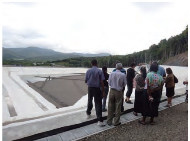
廃棄物最終処分場
